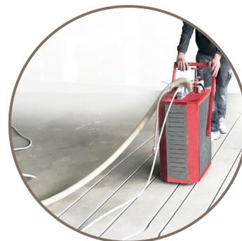
Um die heutigen Normen zu erfüllen ist bei der Verlegung von GIFAfloor PRESTO kein Eingriff an der darunterliegenden Decke notwendig. Vorhandenes Schüttmaterial kann verbleiben. Die Holzbalkenzwischenräume werden mit Dämmmaterial verfüllt.
